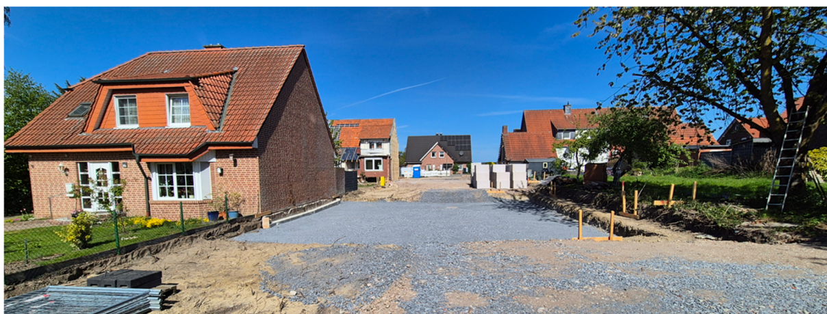
Sicht in Richtung Nikolausstraße (Mai 2026)
