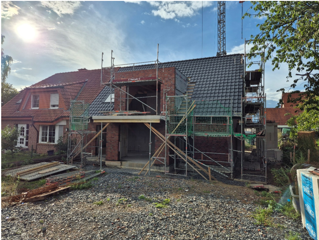
Frontansicht des Gebäudes (August 2026)
