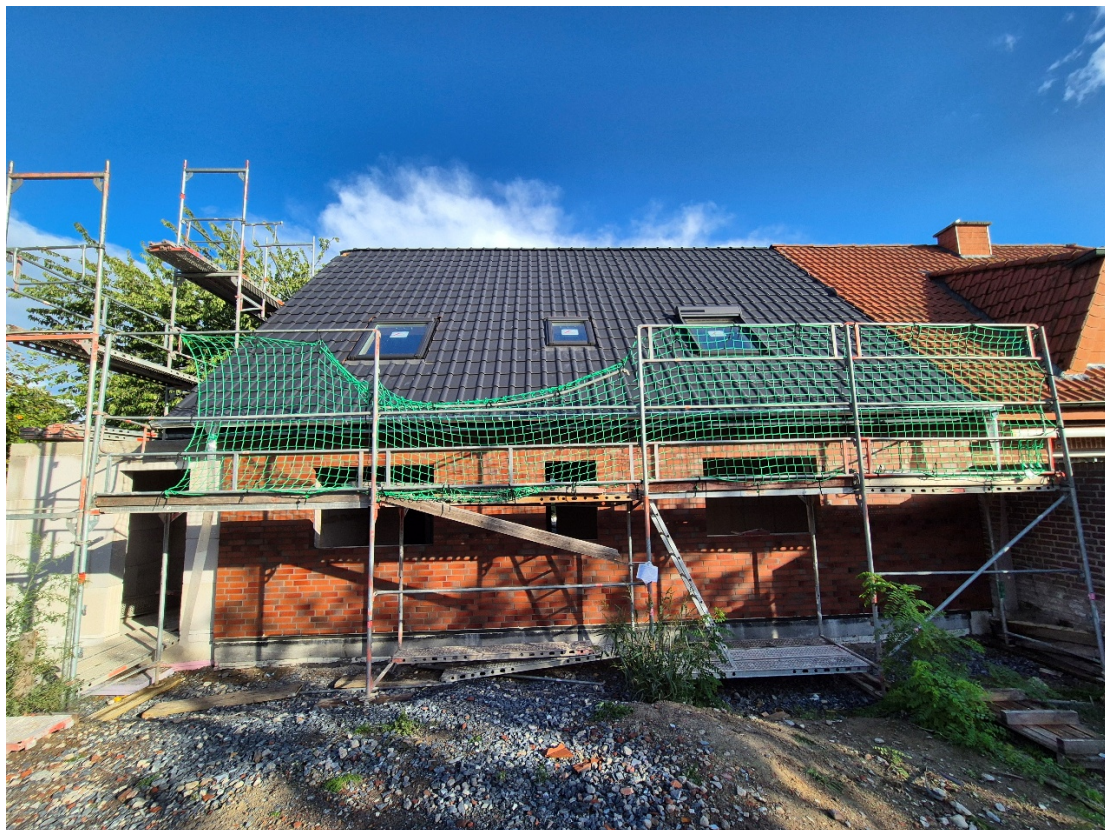
Rückansicht des Gebäudes (August 2026)
