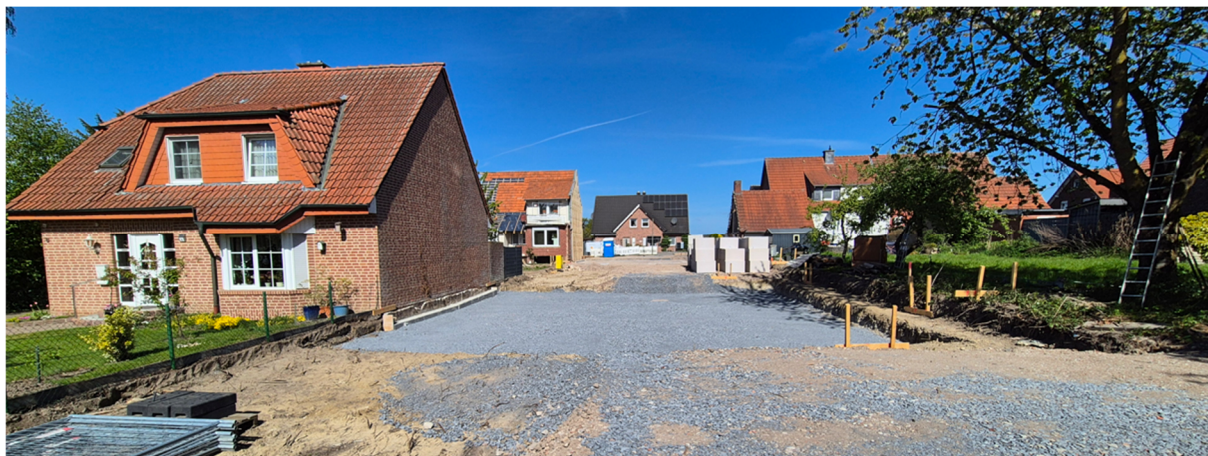
Sicht in Richtung Nikolausstraße (Mai 2026)
