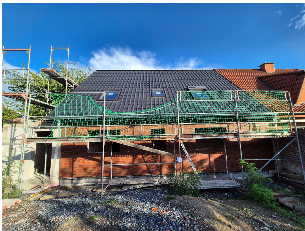
Rückansicht des Gebäudes (August 2026)
