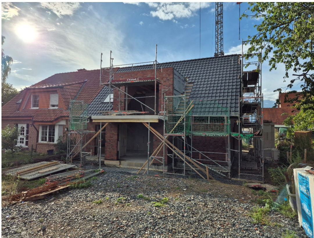
Frontansicht des Gebäudes (August 2026)
